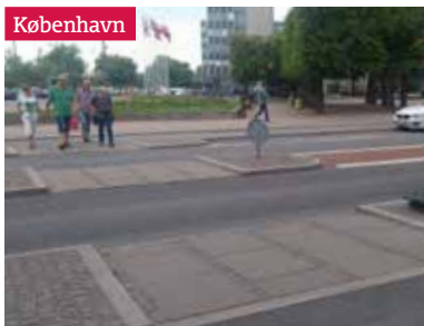
Eksempel på en overgang, hvor gående let kan krydse vejen, da medianen muliggør, at gående kun skal holde øje med én køreretning ad gangen, og kan få en pause halvvejs
