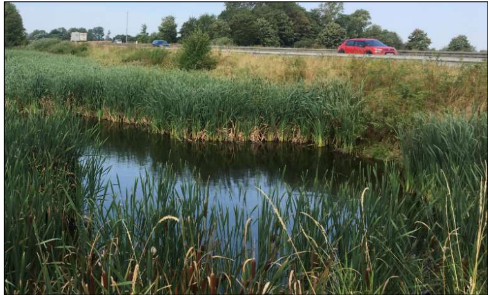
Figur 16: Forsinkelsesbassin ved motorvejsanlæg.
