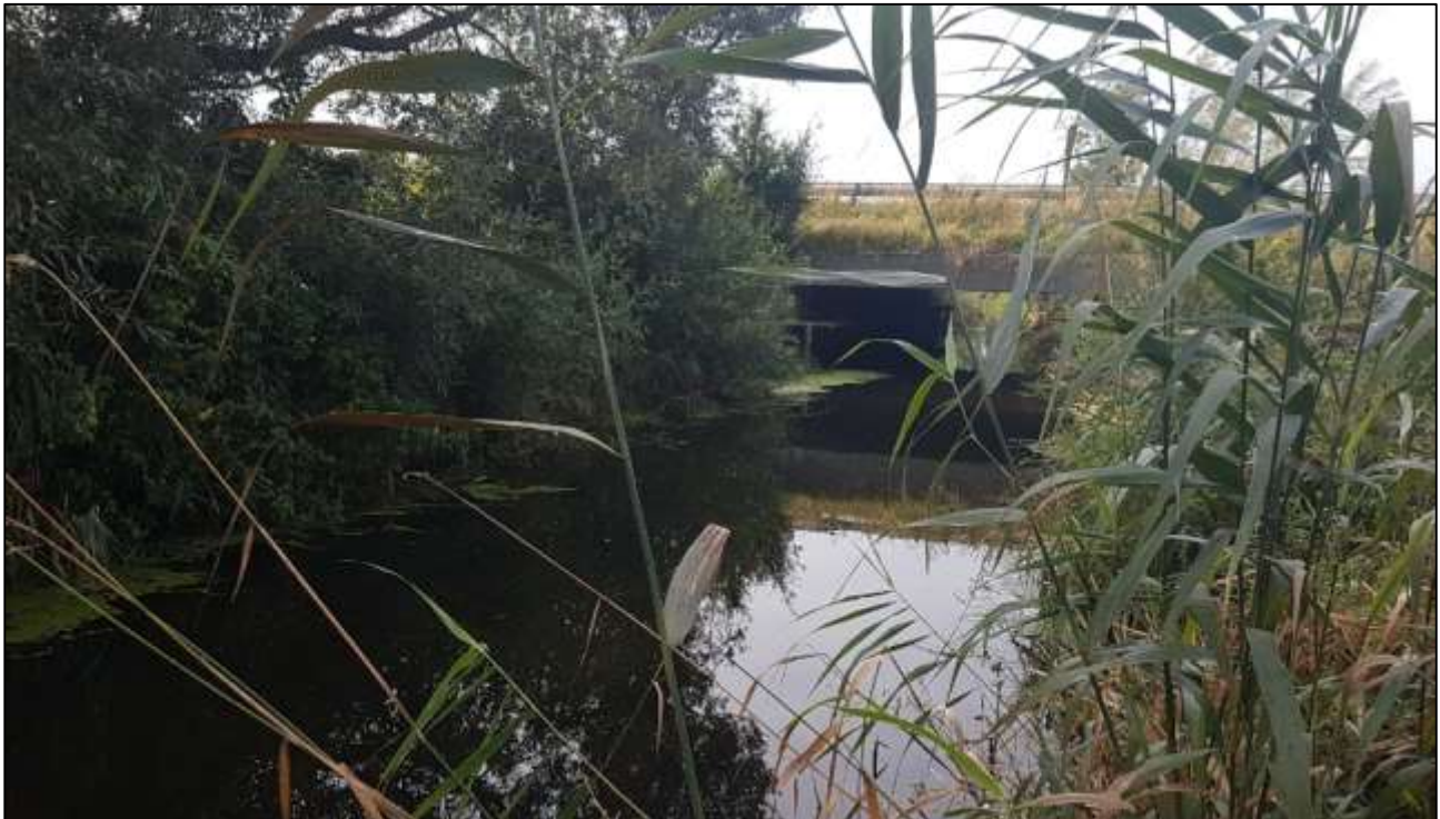
Figur 6: Udløb under Fynske Motorvej i st. 9.012 m set i medstrøms retning.
