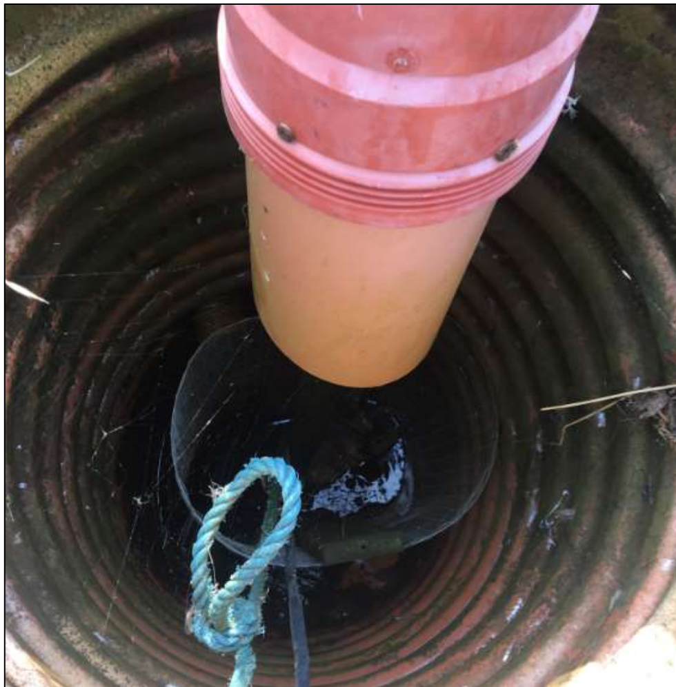
Figur 18: Dykpumpe placeret i brønd ved den østlige ende af grøften.
