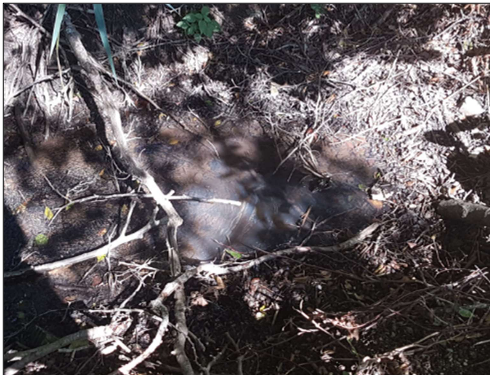
Figur 24: Indløb i neddykket rørlagt forløb i afvandingsystem 9.
