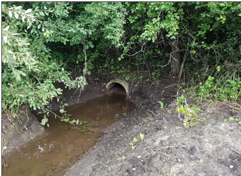
Figur 12: Nyligt opgravet rørudløb i Langæbleafløbet ved st. 190 m.
