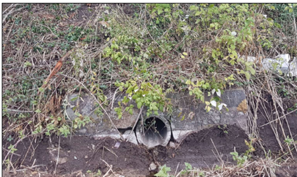
Figur 19: Udløb i grøft vest for Svendborg Landevej.
