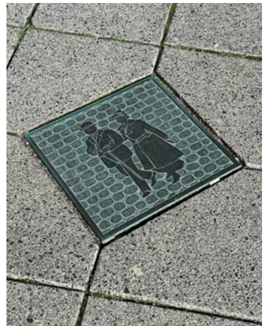
Udsmykning i belægningen på 'Rigets Hovedstrøg'. Strøget går fra havnen til Landporten og omfatter blandt andet Kongegade og Korsgade.
