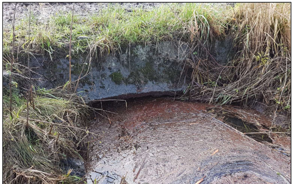
Figur 11: Overkørsel ved st. 480 m.
