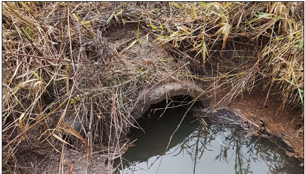
Figur 9: Overkørsel ved st. 283 m.
