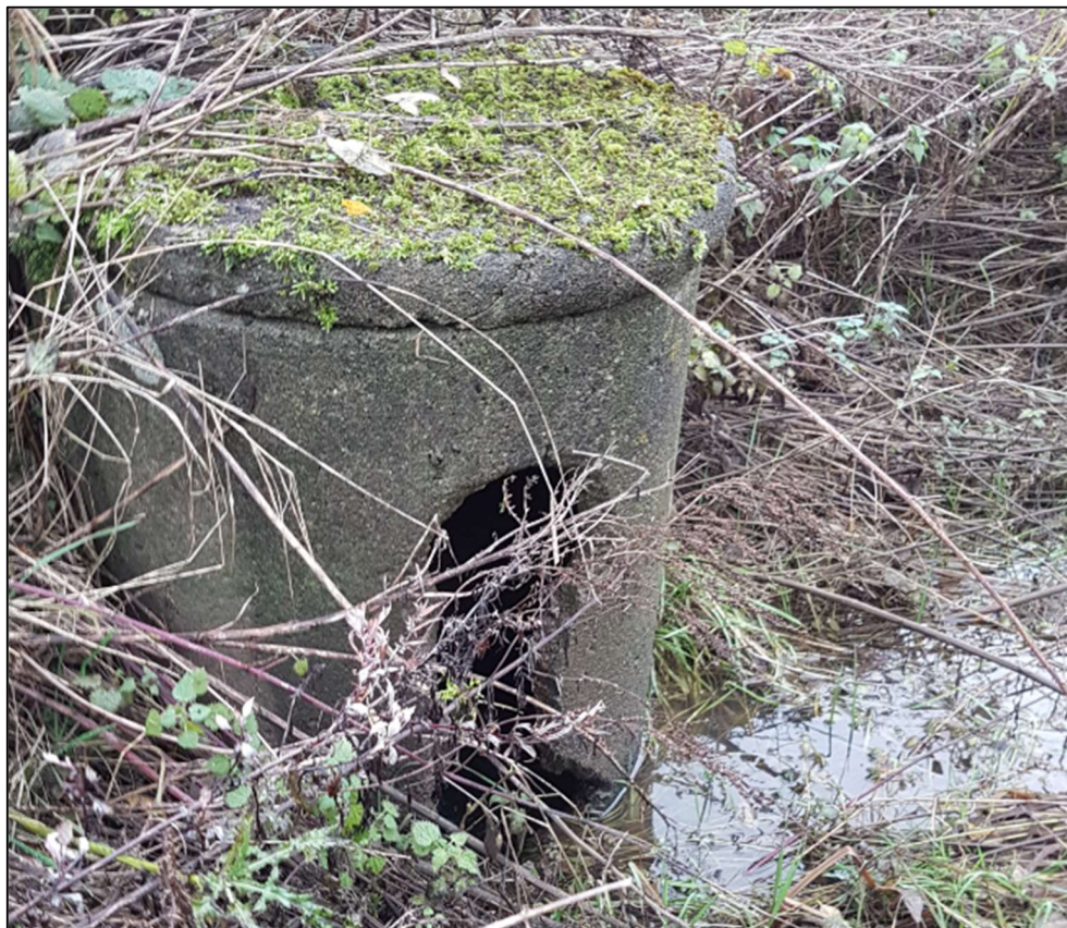
Figur 16: Brønd med udløb fra søen i afvandingssystem 1.
