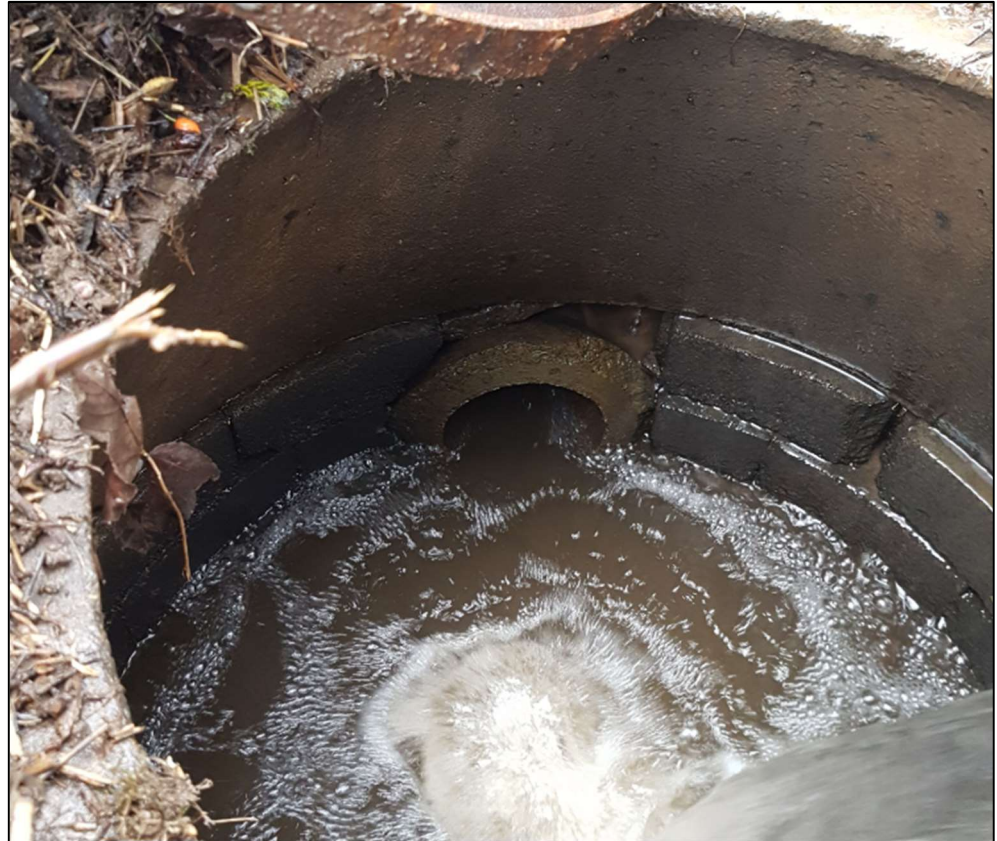
Figur 14: Brønd ved Rygårdsvej med tilløb fra grøft.
