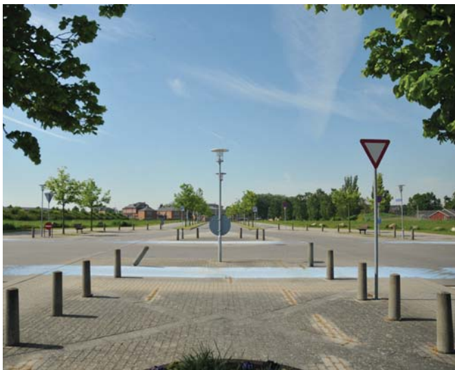
Der savnes information og skiltning ved ankomsten til Nyborg Station, der viser vej til centrum og Nyborg slot.
