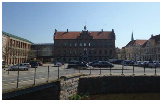
Nyborg Torv 2014 - I dag findes der ingen direkte relation mellem pladsen og Rådhuset, bilen har annekteret pladsen og blokerer bevægelsen for gående.
